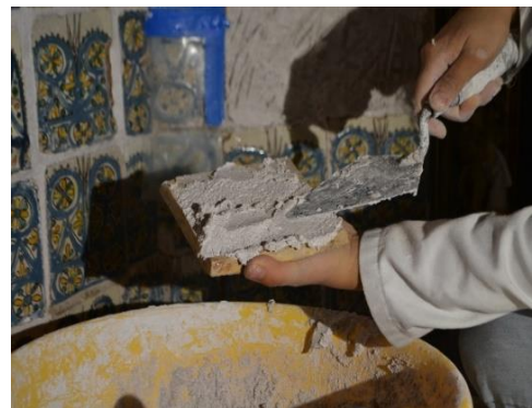
Figura 10. Aplicación de mortero de cal y arena durante el proceso de recolocación (Marín, S. 2016)
