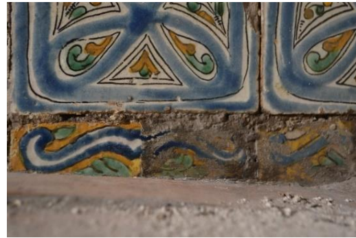
Figura 12. Testigo de limpieza en una de las cenefas policromas localizadas en la parte inferior del muro noroeste (Correa, S. 2016)
