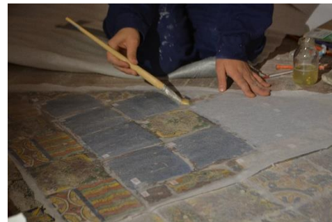
Figura 14. Aplicación de velado de protección (Correa, S. 2017).
