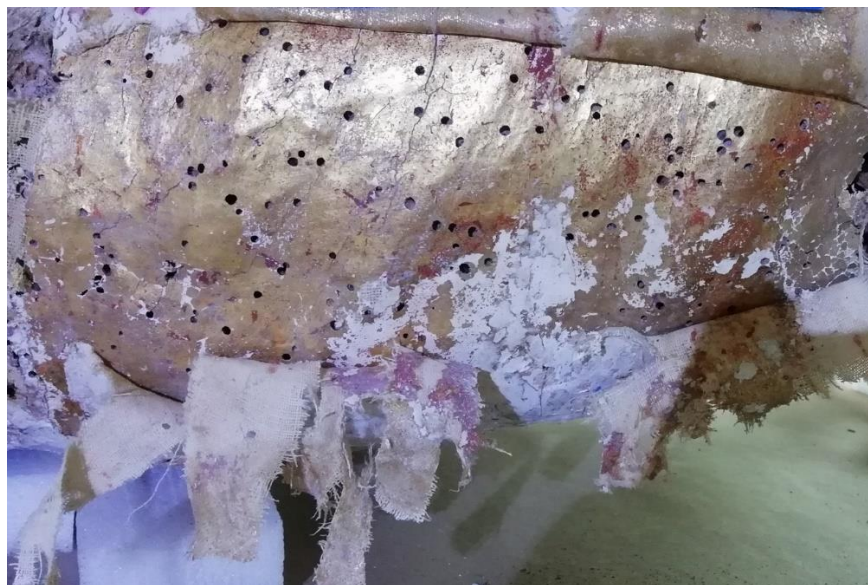
Imagen 8. Detalle de primer cendal dorado, cubierto con enlizado debido al ataque de insectos xilófagos.
