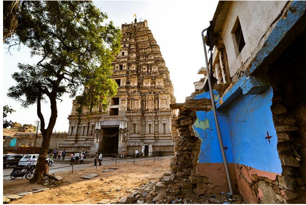
El Templo de Virupaksha y una vivienda en demolición, donde se observa la marca en forma de cruz roja para su demolición. Fotografía de Gethin Chamberlain, The Observer.
